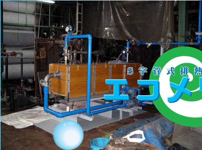
S字管式排熱回収装置
